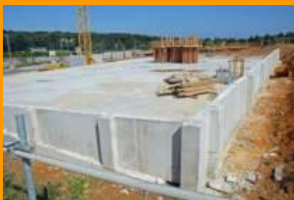
La dalle de béton a été coulée en juillet
