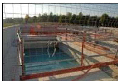
Les travaux en cours
